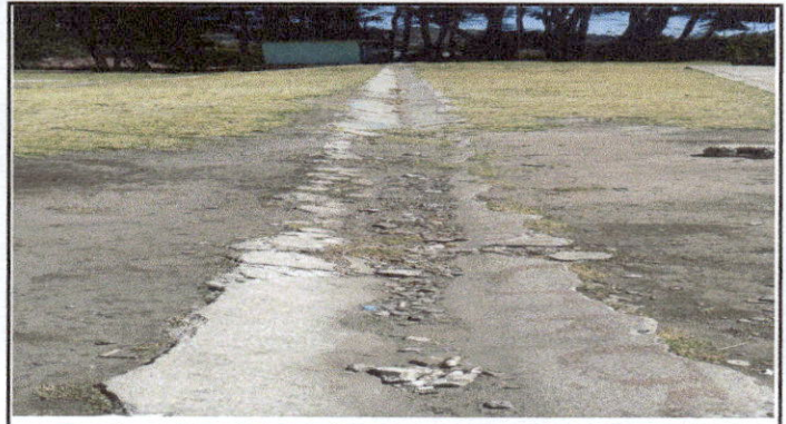
Foto 2. Reparación de Cuneta
