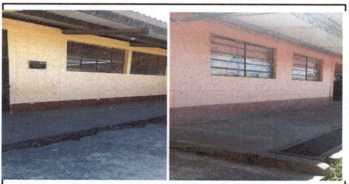
Foto 6. Pintura en muros
