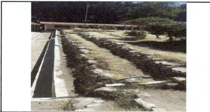
Foto 5. Remoción de gradas de piedra
