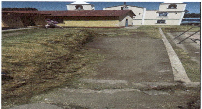
Foto 4 Sustitución de plancha
