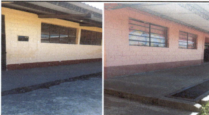
Foto 3. Pintura en muros
